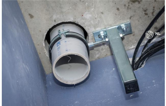
Figura 11: Fijación a elementos que contienen masa.
