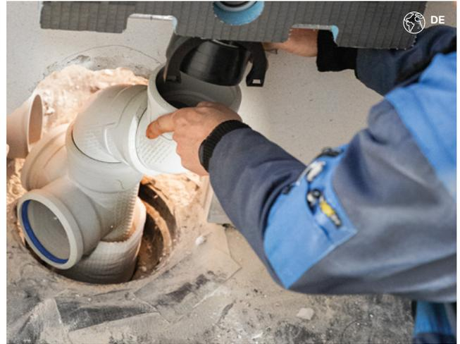
Figura 42: Configuración de un sistema sanitario para una losa de piso.
