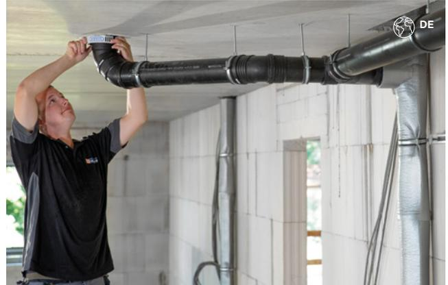
Figura 39: Tubería de aguas residuales con aislamiento acústico.
