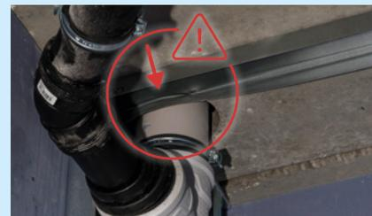
Figura 41: Evitar el contacto con perfiles.
