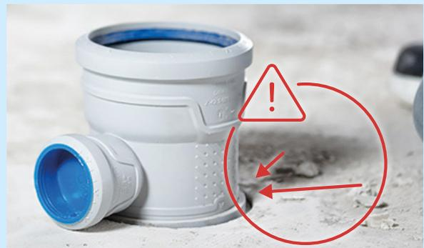
Figura 21: Los escombros de la construcción como un puente de sonido transmitido por la estructura.
