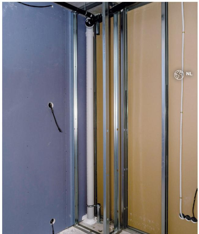
Figura 12: Paredes de lámina de yeso con fijación mediante escuadras a techo y suelo.
