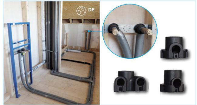
Figura 36: Conjuntos de aislamiento acústico.
