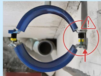
Figura 40: Alineación correcta de los soportes de tubería.
