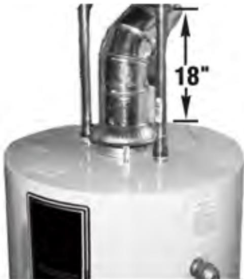
Le SUPERPEX peut être branché directement au mamelon du chauffe-eau sur un chauffe-eau électrique à l'aide de raccords d'extrémité métallique.
