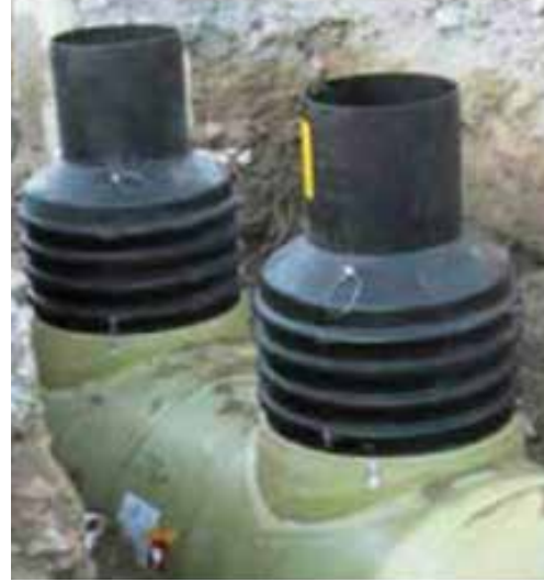
Şekil 6: EuroHUK 600 muayene bacası uygulaması
