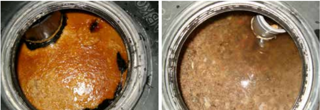
Şekil 2: Dolu yağ ayırıcıların üstten görünüşü
