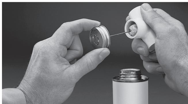
4. À l'aide d'un applicateur ou d'un pinceau à soies naturelles, appliquez généreusement la colle à solvant sur le tuyau et avec parcimonie dans le raccord à emboîtement. Appliquez uniquement de la colle pour PVC-C conforme aux normes CSA B137.6 et ASTM F493.
